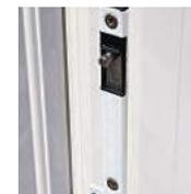
Verrou de maintien bas suivant dimension (à partir de 5 vantaux par côté)
